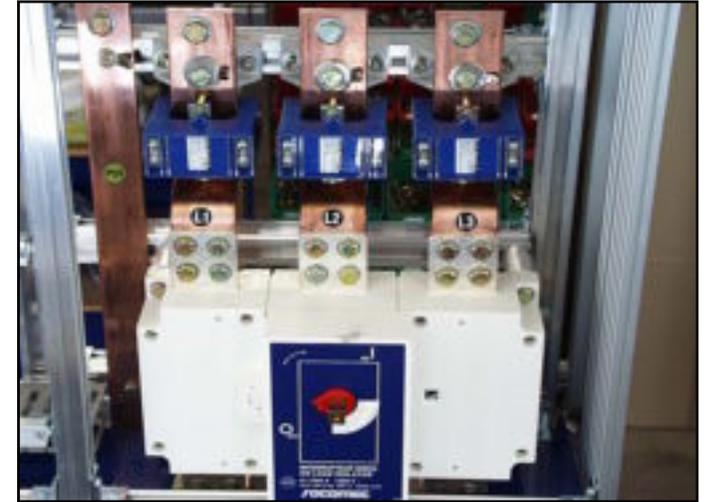
Трансформаторы тока низкого напряжения
